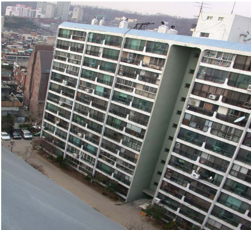
Abbildung 14: Vorderseite des B Gebäudes
