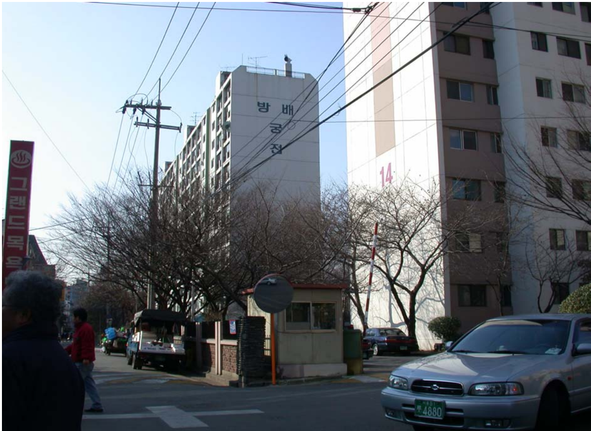
Abbildung 13: In der Mitte des Bildes ist in Längsrichtung das A Gebäude zu sehen
