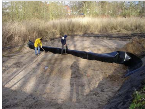
Abbildung 10: Einbau des Trenndamms in Seg. I für die hydraulischen Hochleistungsversuche bei halbiertem Filterfläche.
