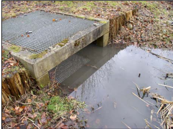
Abbildung 6: Ablaufbauwerk des RHB (links: RHB mit hohem Wasserstand; rechts: RHB mit Niedrigwasser, der bewachsene Schotterdamm im Vordergrund erkennbar).
