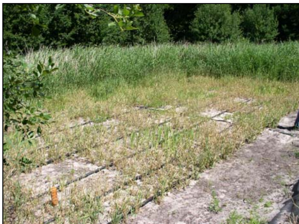
Abbildung 7: Das Untersuchungsobjekt Filtersegment I (links: Sommer 2008, erkennbar sind Bewässerungsrohre und Trenndamm der Hochleistungsfläche, vgl. Abb. 10; im Hintergrund die schilfbestandenen Filtersegmente III und IV; rechts: Aspekt im Mai 2009).
