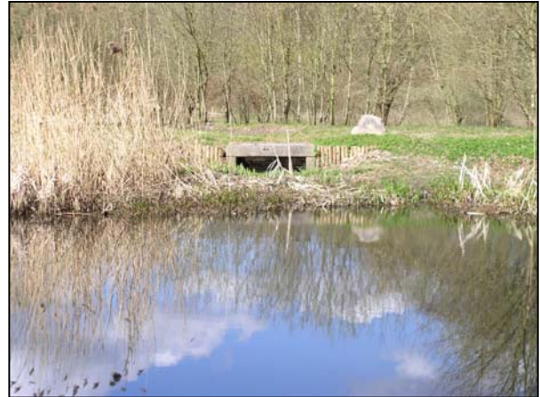
Abbildung 6: Ablaufbauwerk des RHB (links: RHB mit hohem Wasserstand; rechts: RHB mit Niedrigwasser, der bewachsene Schotterdamm im Vordergrund erkennbar).
