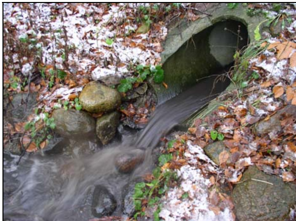
Abbildung 4: Zulauf zum Rückhaltebecken (links: einsetzender „first flush“; rechts: Trockenwetterzufluss, im Vordergrund Tosbecken).
